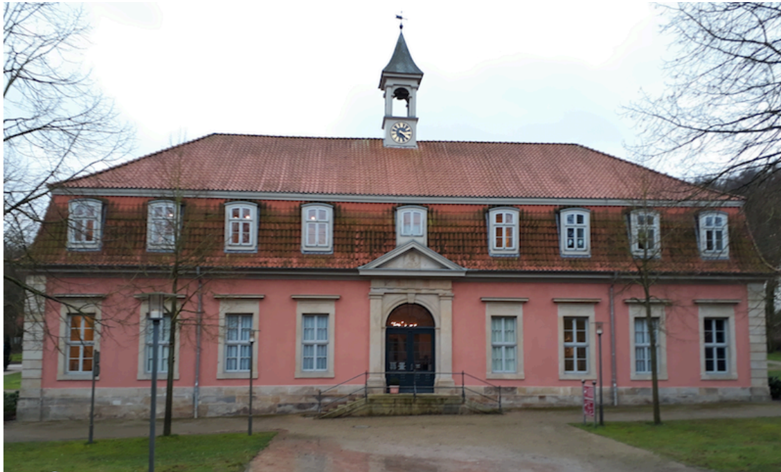
Das Neue Badehaus im Gesundbrunnen zu Rehburg (erbaut 1779 bis 1786), Vorderansicht. Foto: Hanna Cassens, aufgenommen am 5.1.2018
