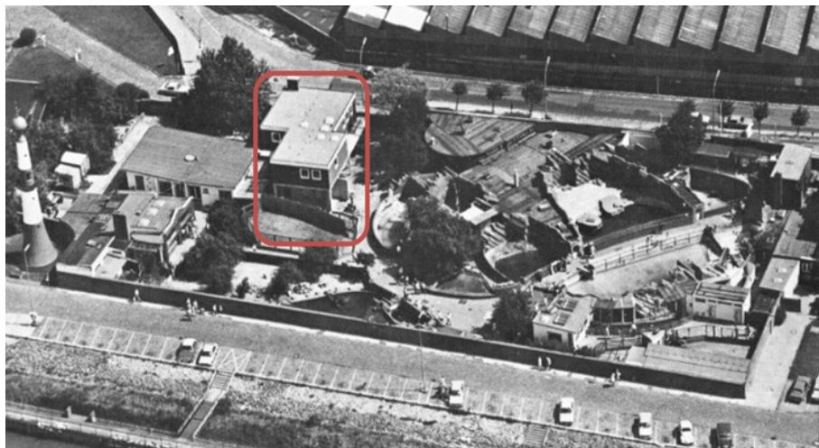
Abbildung 45: Die Tiergrotten in den 1970er Jahren mit neuem Verwaltungsgebäude (rot markiert) (Archiv Zoo am Meer Bremerhaven, verändert).
