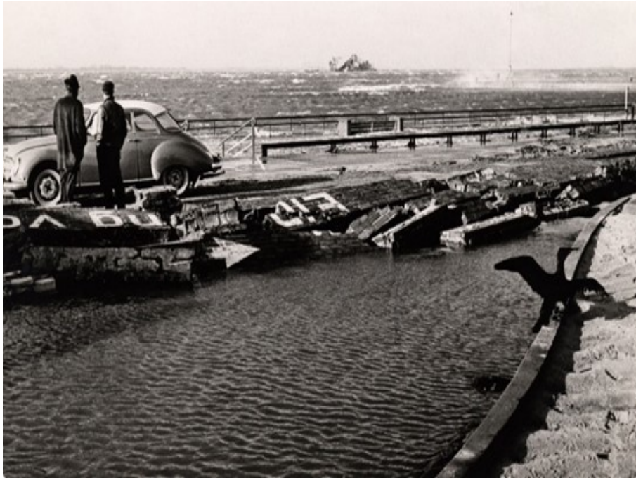
Abbildung 44: Eingestürzte Zoomauer nach der Sturmflut 1962 (Archiv Zoo am Meer Bremerhaven).
