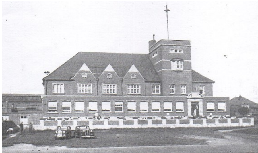
Abbildung 26: Städtische Strandhalle Bremerhaven 1936 (Junker, 1936, S. 4).
