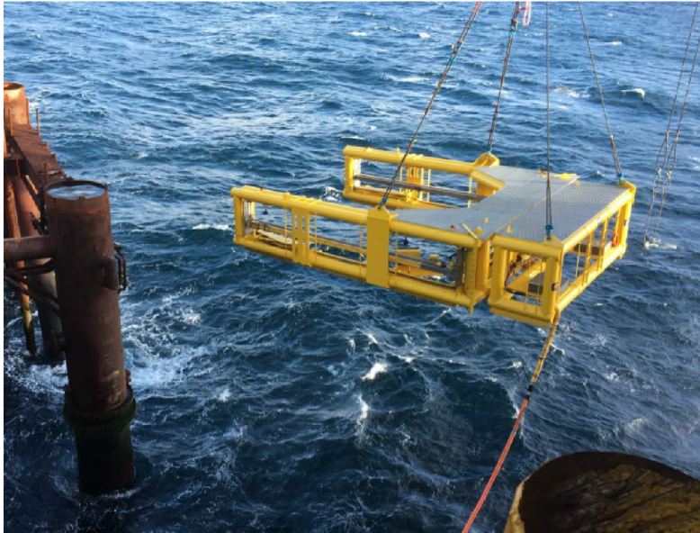
Abbildung 43: Herablassen einer 240-Zoll Diamantseilsäge (CUT UK Ltd 2019b) Abdruck mit Genehmigung von CUT UK.
