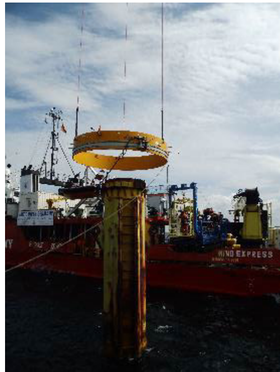
Abbildung 41: Wasserstrahlschneidwerkzeug zum Schneiden von außen (Steffen 2016) Abdruck mit Genehmigung von Aquatec On-/ Offshore Service GmbH
