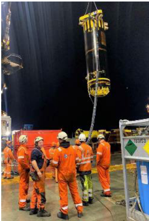
Abbildung 40: Wasserstrahlschneidwerkzeug zum Schneiden von innen mit abgeschnittenem Pfahl (DECO Subsea NV 2020) Abdruck mit Genehmigung von DECO Subsea N.V.
