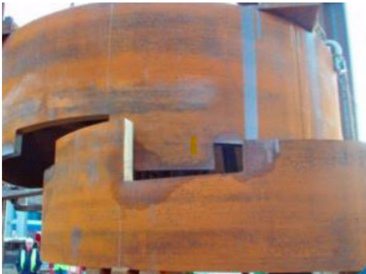
Abbildung 44: Stufenschnitt in einem Stahlrohr (CUT UK Ltd 2019b) Abdruck mit Genehmigung von CUT UK.
