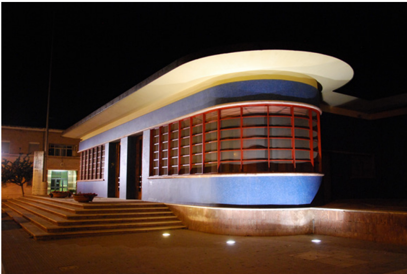
Abbildung 8: Ehemaliges Postamt in Sabaudia; © Rainer Hartmann
