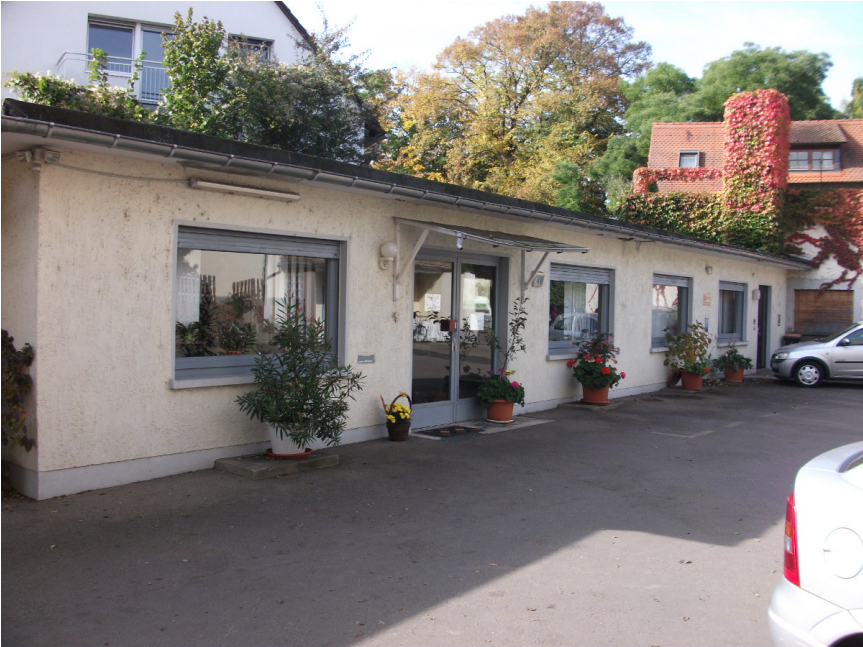
Abb. 5.1.: Erstes Gebäude des CHZ von Januar 2004 bis 31. Dezember 2013
